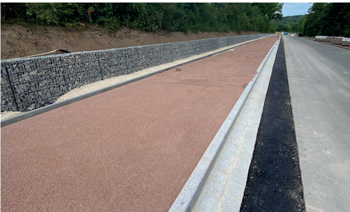
Der neue Radweg entlang der Hauptstraße nähert sich der Fertigstellung. © Gemeinde
